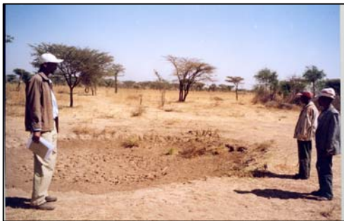
ምስል 1. በኮታ አሰራር ሳቢያ በርካታ ኩራዎች በዘፈቀደ በመሰራታቸው ከጥቅም ውጪ የሆኑ አሱ (ዱግዳ ቦራ)
